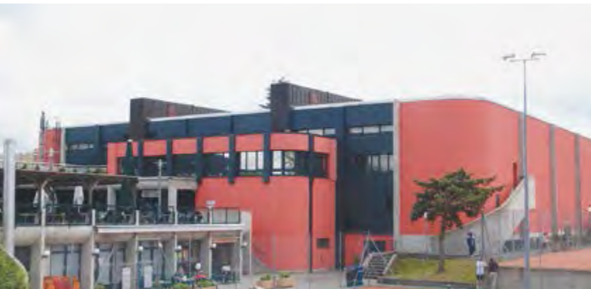
Centre Sportif Sous-Moulin (CSSM)
