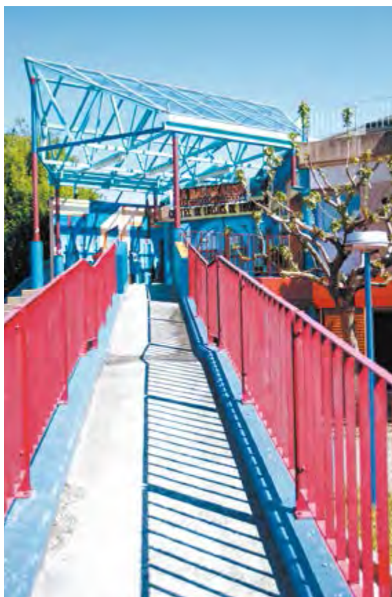
Rampe d'accès à la Maison des quartiers
