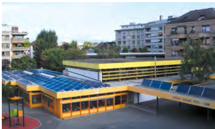
EB4 : Panneaux photovoltaïques sur le toit de l'école Petit-Senn
