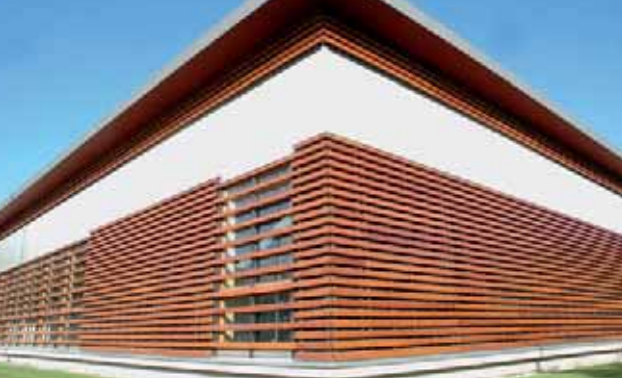
Vue du Centre sportif de Cologny
