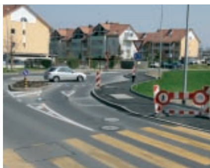
Aménagements en cours route de Pré-Marais / chemin des Rouettes
