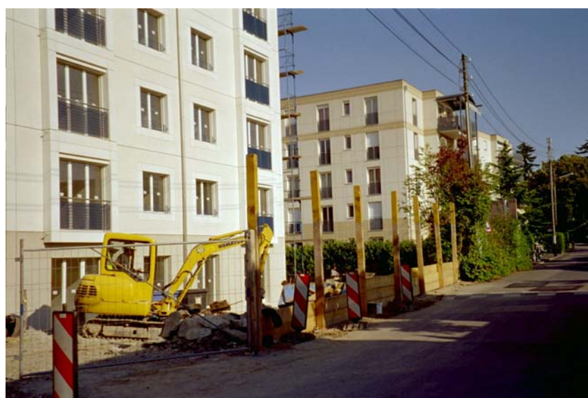
Immeubles en construction chemin Jaques-Attenville
